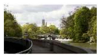
MüMa.V, Blick auf Kabelsteg, DI006699, BSV-
