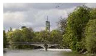
MüMa.V, Blick auf Kabelsteg, DI006698, BSV-
