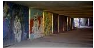
MüMa.V, Fußgängerunterführung Luitpoldbrücke, DI006685, BSV-
