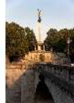
MüMa.V, Terrassenanlage mit Friedensengel, DI009346, BSV-
